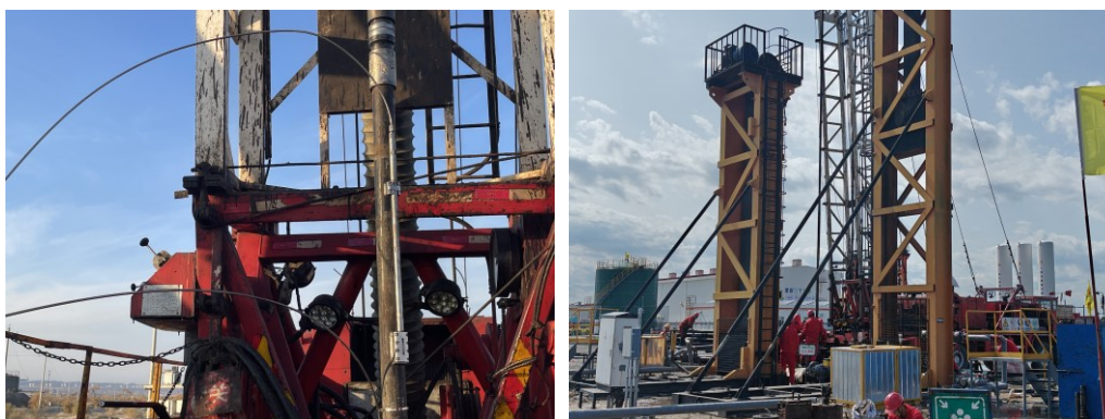
图 2. 某油田 CO 2 驱生产井安装井下腐蚀监测仪现场照片
