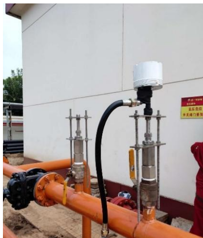
图 2. 电阻腐蚀监测仪安装现场
